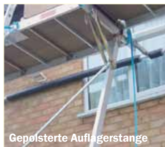
Dachrandsicherung
