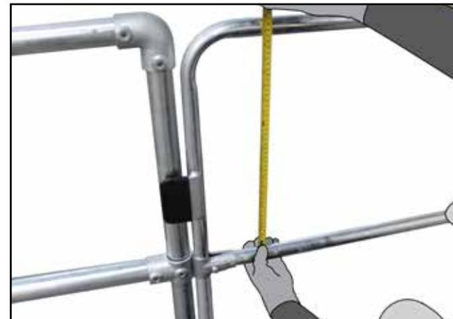
**N.** Benutzen Sie das Maßband, um einen Abstand zwischen oberem und mittlerem Rohr von mindestens 470 mm zu gewährleisten. Passen Sie die Position des mittleren Rohres an, wenn nötig.
