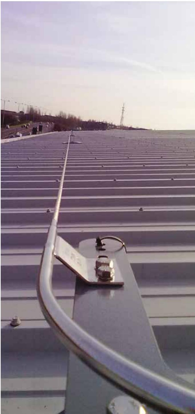
Das horizontale Seilsicherungssystem **KEELINE** soll einen sicheren Zugang zu jedem Bereich eines Daches ermöglichen, indem Arbeiter dauerhaft mit dem Seil verbunden sind und sich frei auf dem Dach bewegen können. Das System verwendet ein 8 mm starkes Seil aus Edelstahl. (V4A) Es erlaubt Spannweiten von bis zu 12 m zwischen den einzelnen Pfosten und kann gleichzeitig von bis zu drei Nutzern verwendet werden.
