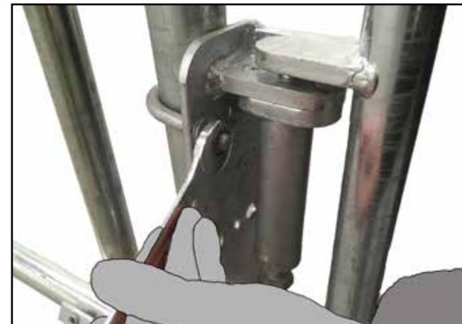
**B.** Befestigen Sie den oberen U-Bügel mit einer M8 oder M10 Unterlegscheibe und einer Mutter am Stützbein bzw. an der Stützstruktur und ziehen Sie sie fest.
