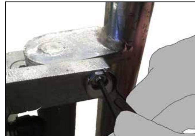
**N.** Benutzen Sie einen M6 Ringschlüssel und einen 4mm Sechskantschlüssel, lockern Sie die Sicherungsmutter und stellen Sie die Madenschraube so ein, dass beide Türen in der Flucht ausgereicht sind.
