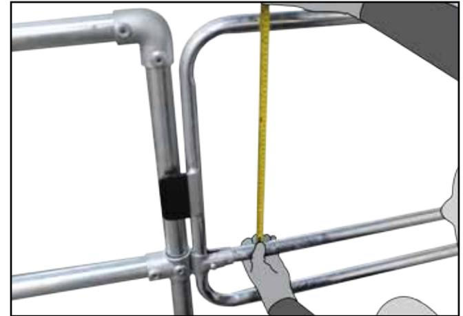
**Q.** Benutzen Sie das Maßband, um einen Abstand zwischen oberem und mittlerem Rohr von mindestens 470 mm zu gewährleisten. Passen Sie die Position des mittleren Rohres an, wenn nötig.
