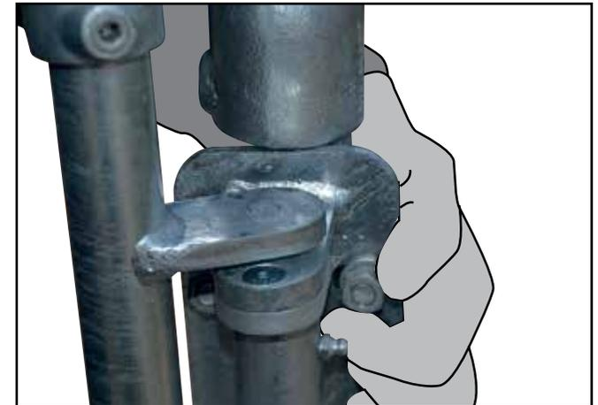
**B.** Befestigen Sie den oberen U-Bügel mit einer M8 oder M10 Unterlegscheibe und einer Mutter am Stützbein bzw. an der Stützstruktur und ziehen Sie sie fest.
