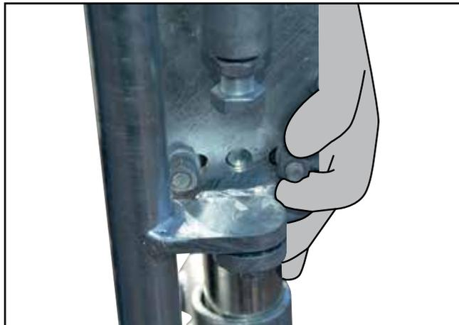
**D.** Befestigen Sie den unteren U-Bügel und den Stützfuß bzw. die Stützstruktur mit einer M8 oder M10 Unterlegscheibe und einer M8 oder M10 Mutter und ziehen Sie diese fest.
