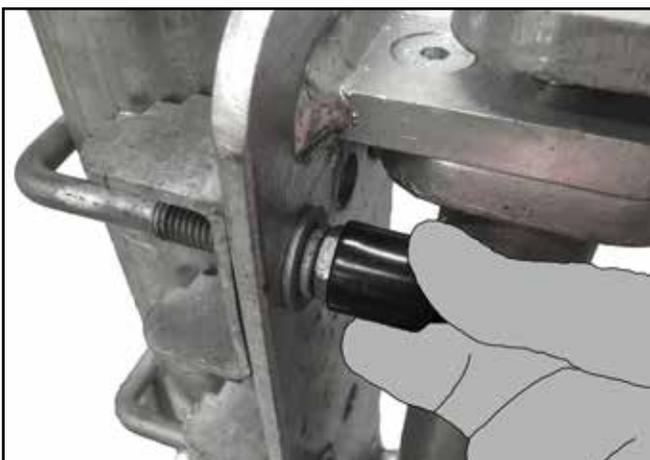
**O.** Stellen Sie sicher, dass alle Muttern und Schrauben (außer die Madenschraube) am Gate mit 39Nm angezogen sind. Setzen Sie die Kunststoffkappen über die Muttern. Stellen Sie sicher, dass die Konstruktion an dem die Tür montiert ist, fixiert ist und alle Muttern und Schrauben nach Vorgaben des Herstellers angezogen sind..
