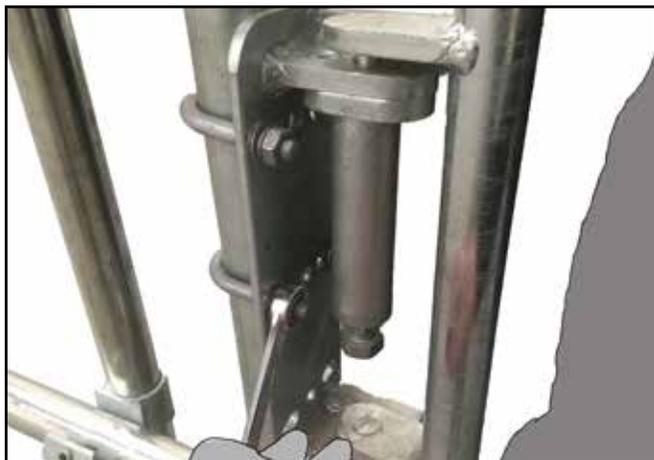
**C.** Führen Sie den unteren U-Bügel um den Stützfuß bzw. um die Stützstruktur durch die mittleren Löcher der Befestigungsplatte..
