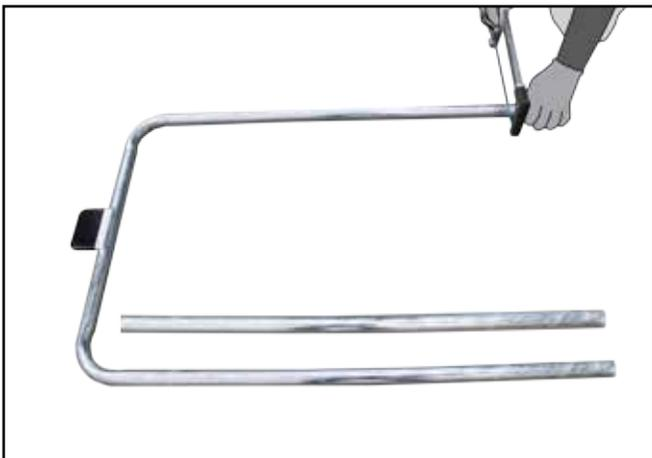
**I.** Schneiden Sie vorsichtig alle drei Rohre mit einer Metallsäge o. ä. wie abgebildet zu. Sprühen Sie die Kanten zum Schutz vor Korrosion mit Zinkspray o. ä. ein.
