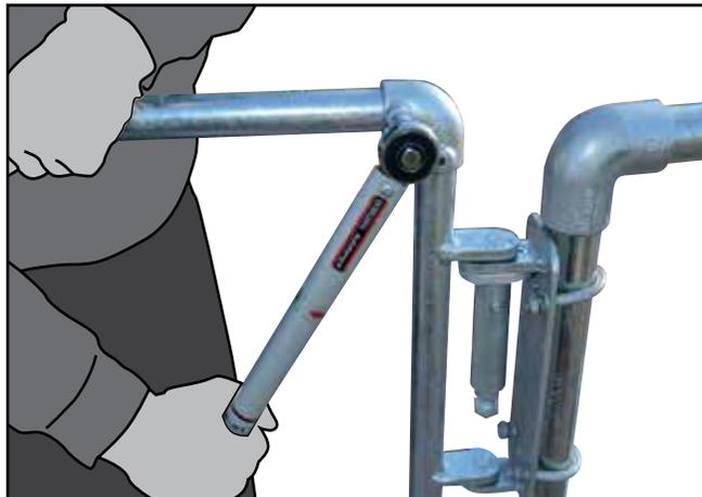
**J.** Setzen Sie das obere und untere Rohr wieder sorgfältig in die Rohrverbinder ein. Stellen Sie sicher, dass sich der Anschlag auf der richtigen Seite des Stützfußes befindet. Richten Sie die Tür mit einer Wasserwaage aus. Ziehen Sie die Madenschrauben mit 39 Nm fest. Benutzen Sie hierfür einen Drehmomentschlüssel mit Innensechskantaufsatz.
