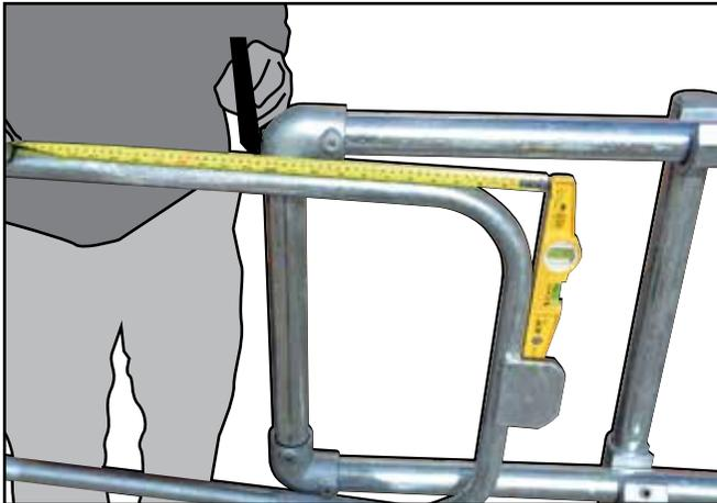
**F.** Um die Sicherheitstür auf die richtige Länge einzukürzen, positionieren Sie ein Metermaß und eine magnetische Wasserwaage, wie dargestellt. Messen Sie den Abstand bis an den Punkt, an dem die Außenkante des vertikalen Rohres der Sicherheitstür auf den Geländerpfosten trifft.
