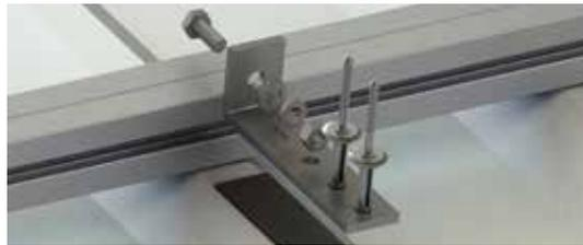
Befestigen Sie den Querlaufsteg genauso am Dachprofil wie die Längsversionen. Entfernen Sie die Tritte vom Laufsteg, die den Positionen der Befestigung für das untere Laufstegaluminiumprofil entsprechen. Während der Montage müssen Sie auf die folgenden Punkte achten:
